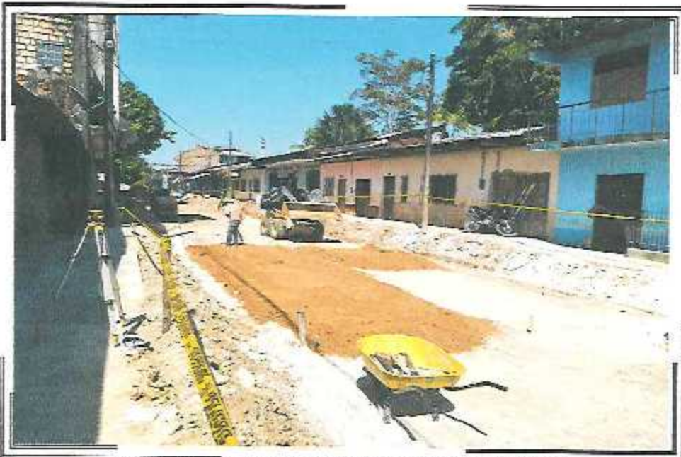
RELLENO CON MATERIAL DE PRESTAMO A-2-4 EN EL PSJ QUINONES TRAMO III
