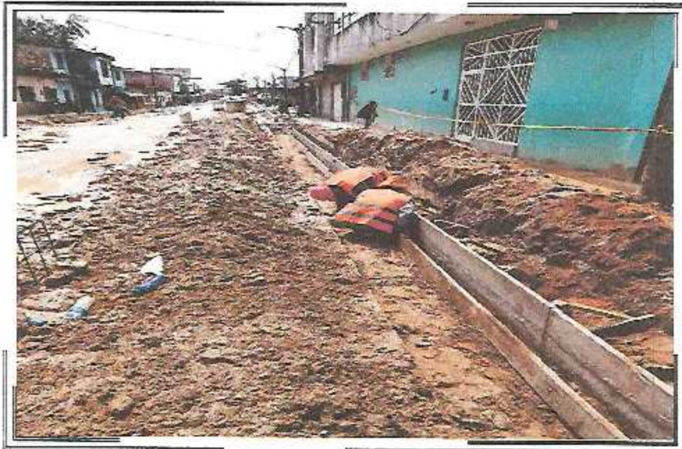
ENCOFRADO PARA SARDINEL PSJ QUIÑONES TRAMO II
