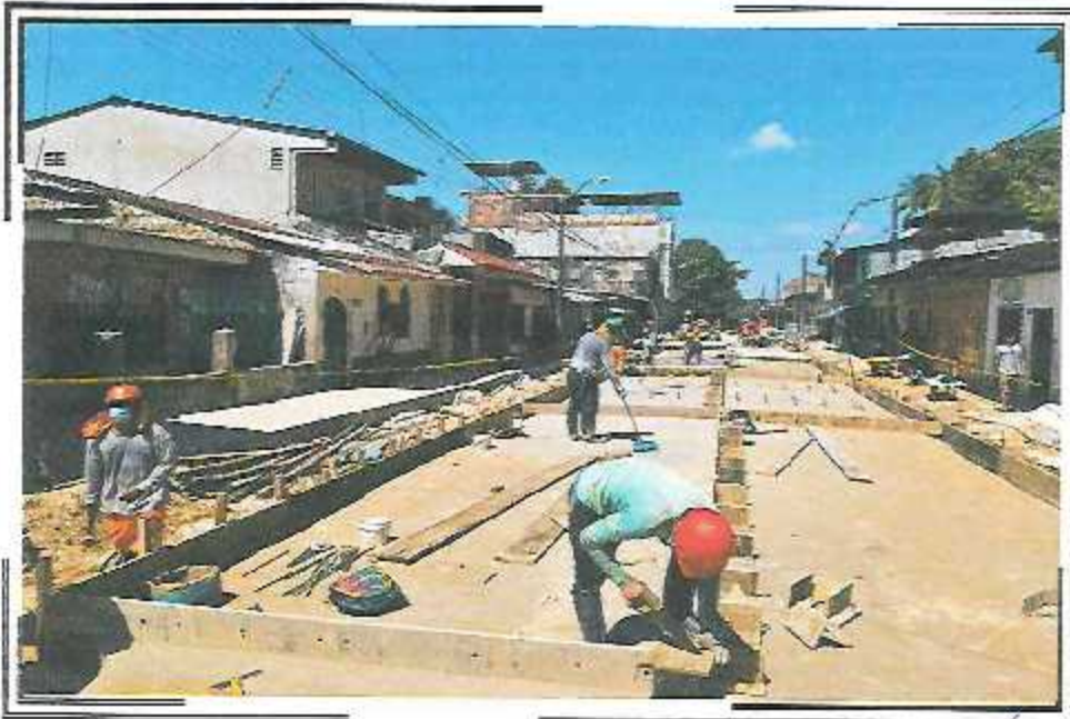
ENCOFRADO DE PAVIMENTO. PSJ QUIÑONES TRAMO III
