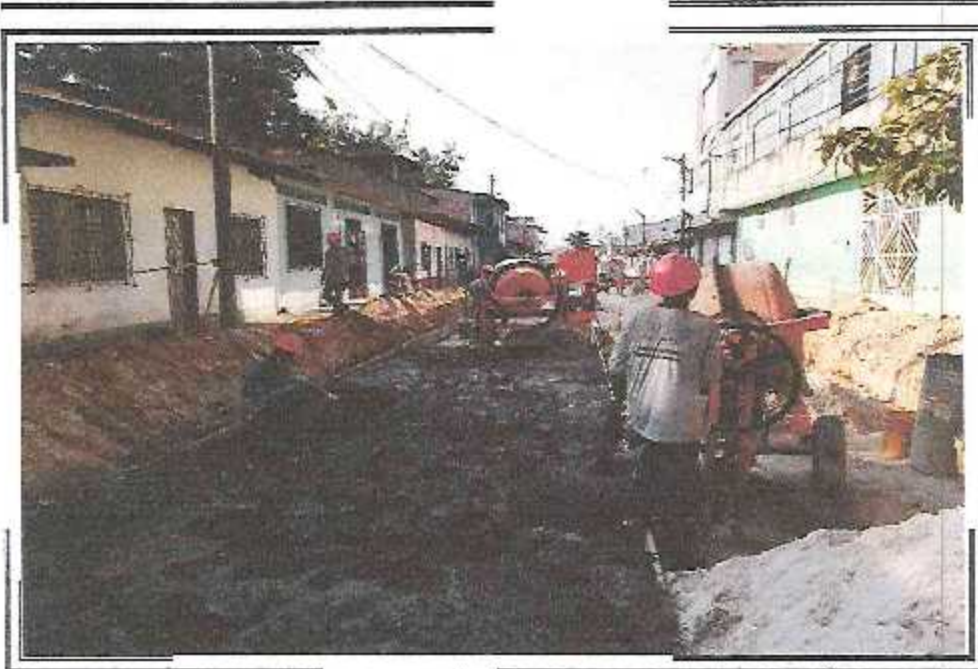
VACEO DE LOSA DE RODADURA PSJ QUIÑONES TRAMO III (CA. ABTAO / AV. DEL EJERCITO)
