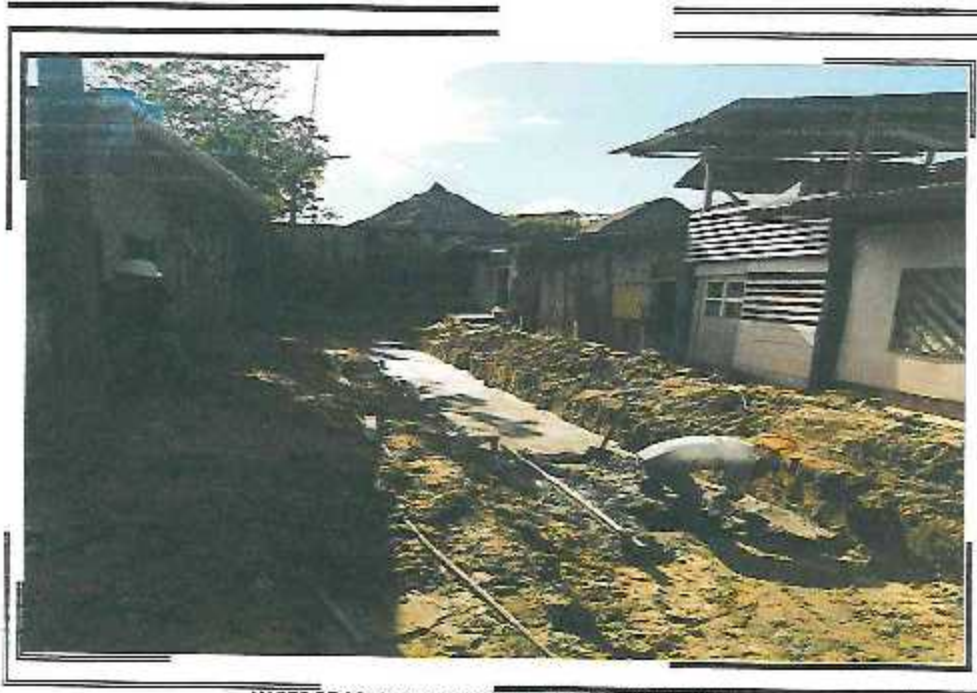
VACEO DE SOLADO DE CANAL MORTERO FC-175 Kg PSJ E.
