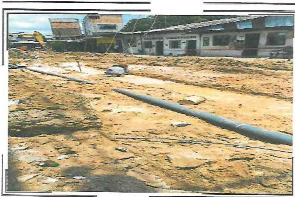
COMPACTACION DE CAMA DE ARENA A-3 PSJ ANACONDA
