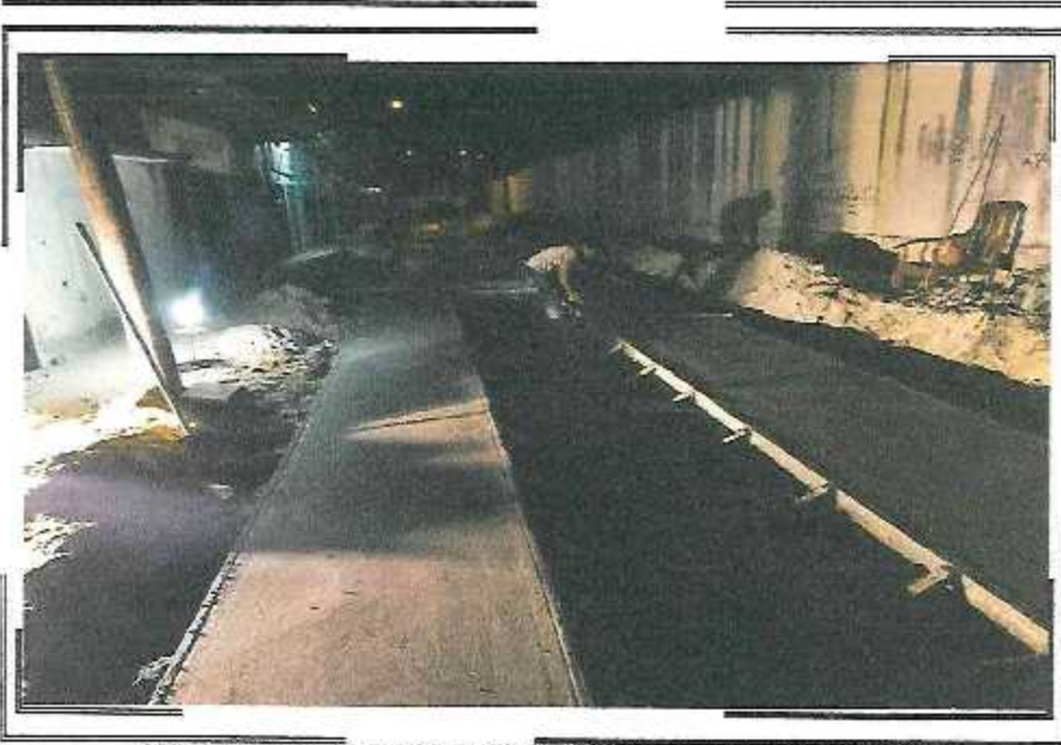
ACAVADO DE LOSA DE RODADURA Fc-210 Kg PSJ QUIÑONES / AV. MARISCAL CACRES.
