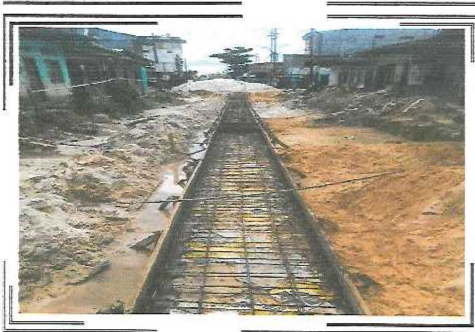
BAJANDO LAS MALLAS DE LOSA SUPERIOR DEL CANAL DE 0.70 X 0.70 DEL P.S.I. QUIÑONES TRAMO II
