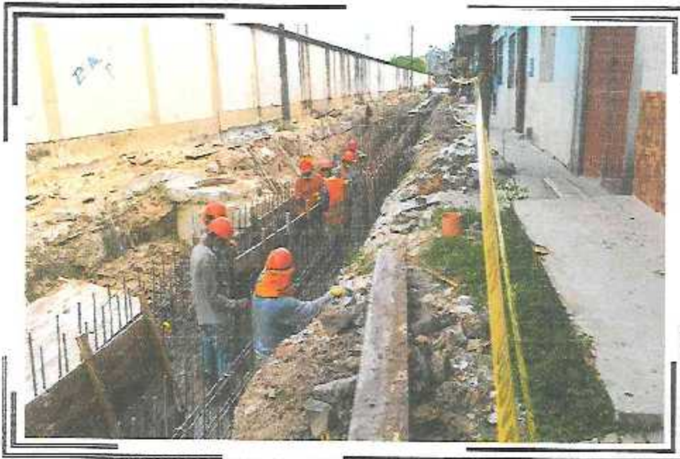
ENCOFRADO DE LATERALES DEL CANAL DE 0.80 X 0.80 P.S.I. QUIÑONES TRAMO I
