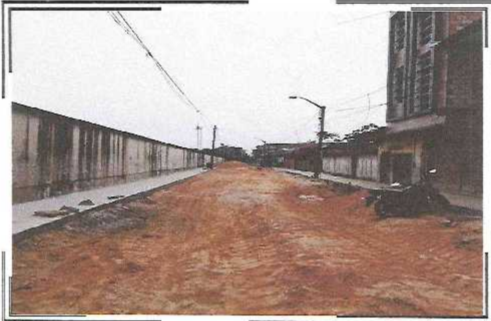
RELLENO CON MATERIAL A-3 PSJ QUIÑONES (AV. CACRFES)
