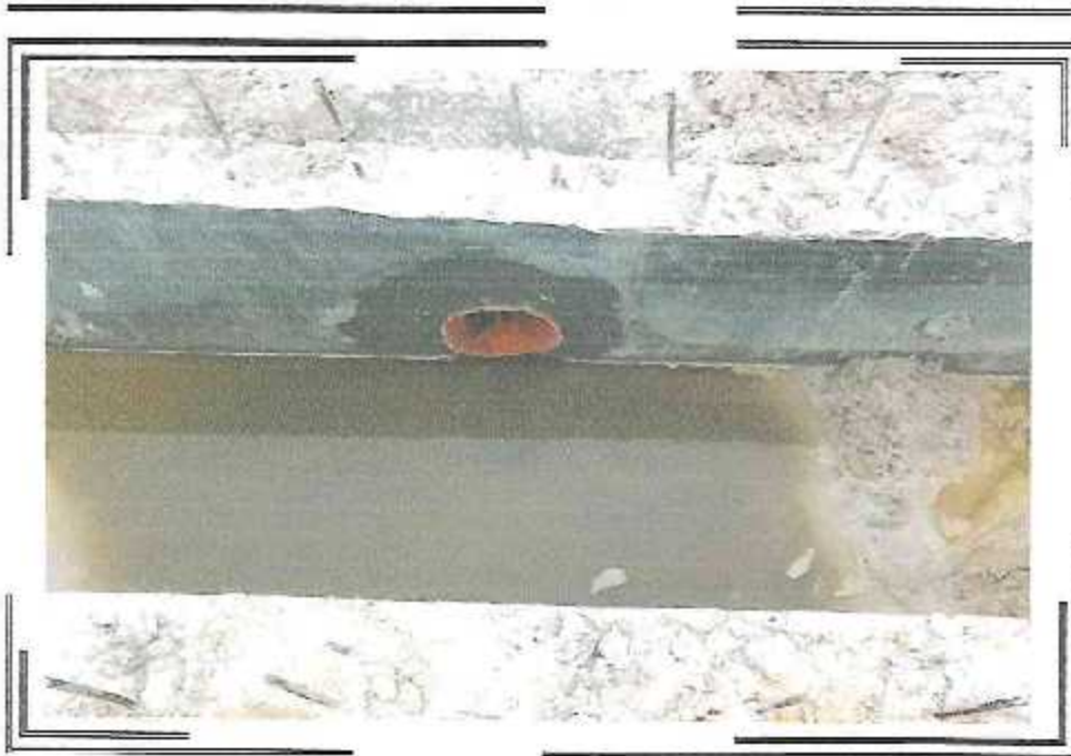
TARRACEO INTERIOR DEL CANAL DE 0.80 X 0.80 DEL PSJ. QUIÑONES TRAMO I
