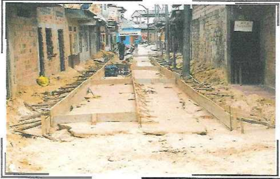
ENCOFRADO DE LOSA DE RODADURA PSJ MIAMI / PSJ QUIÑONES
