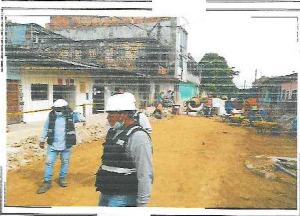
PREPARACION DE MESCLA PARA VACED DE SOLADO PSJ QUIÑONES TRAMO III
