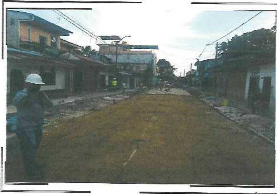
ALINEAMIENTO DE PUNTOS DE NIVEL PARA SOLADO, PSJ QUIÑONES TRAMO III
