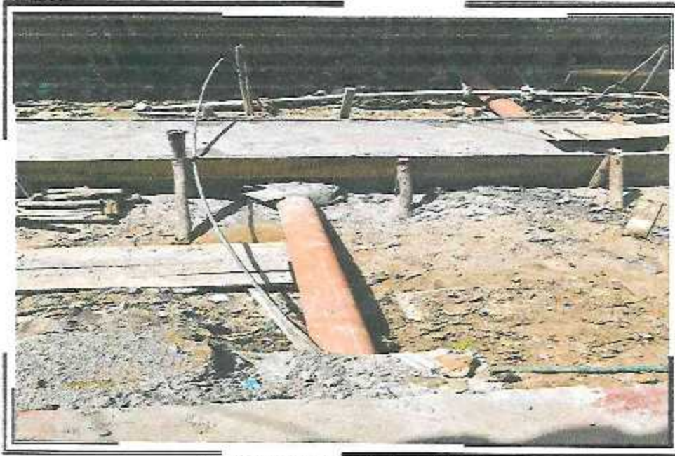
CONEXIONES DE DESAGUE PSJ. GONZALES VIGIL
