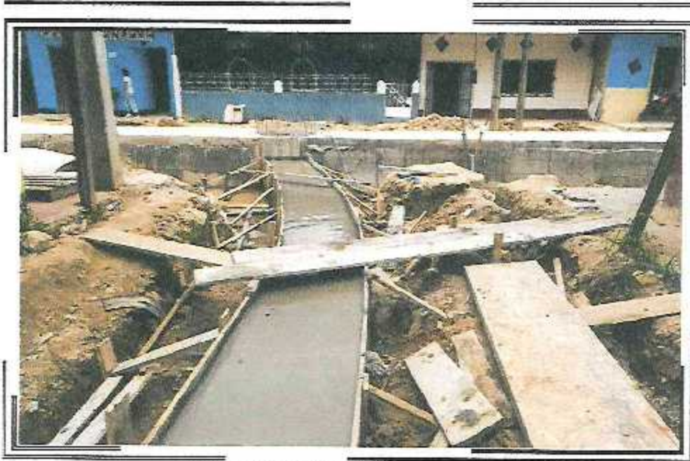
VACEO DE TECHO DE CANAL PSJ "E" MORTERO Fe=210 Kg
