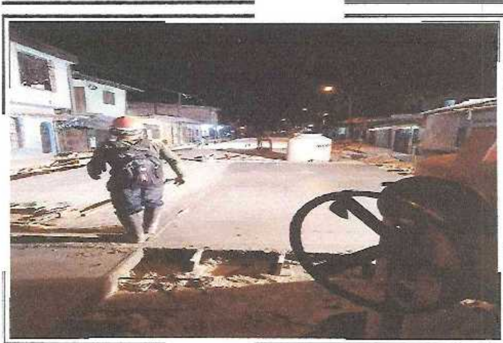
ACABADO DE LOSA DE RODADURA PSJ QUIÑONES TRAMO II
