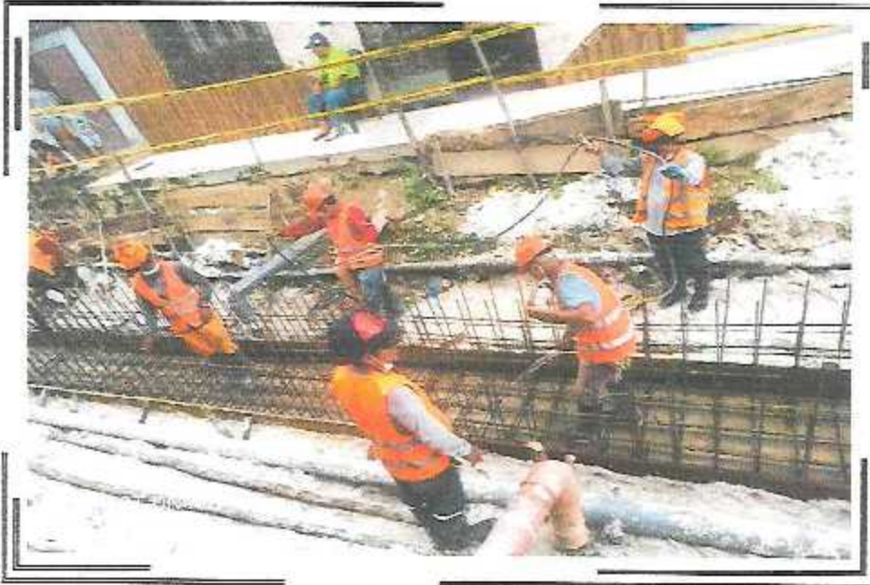
HABILITACION DE ACERO DE 3/8" DEL CANAL DE 0.60 X 0.60 DEL PSJ. GONZALES VIGIL
