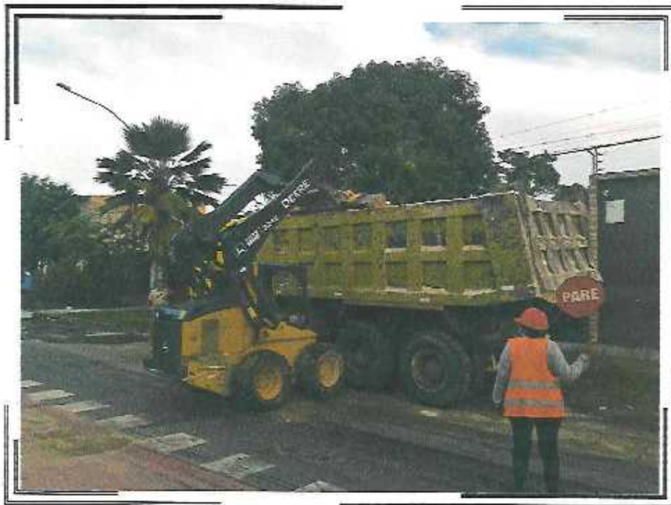
ELIMINACION DE MATERIAL EXCEDENTE EN LA CALLE QUIÑONES CON AV. DEL EJERCITO
