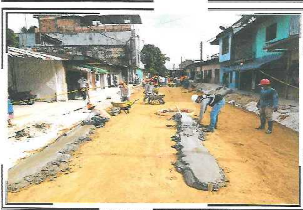
VACEO DE SOLADO PARA PAVIMENTO EN PSJ QUIÑONES TRAMO III
