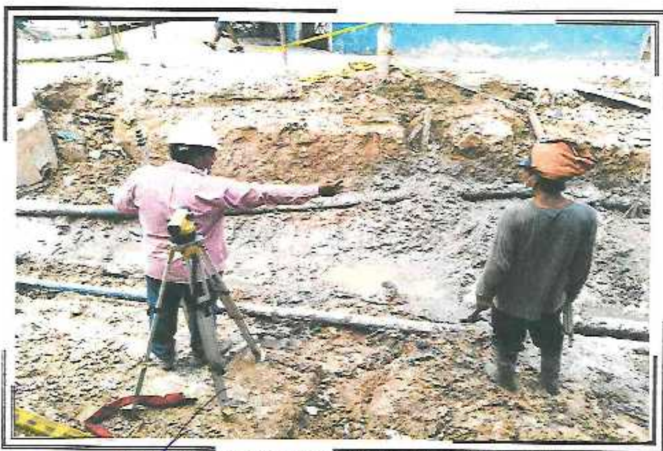
COLOCACION DE PUNTOS DE NIVEL PARA SOLADO EN PSI. GONZALES VIGIL
