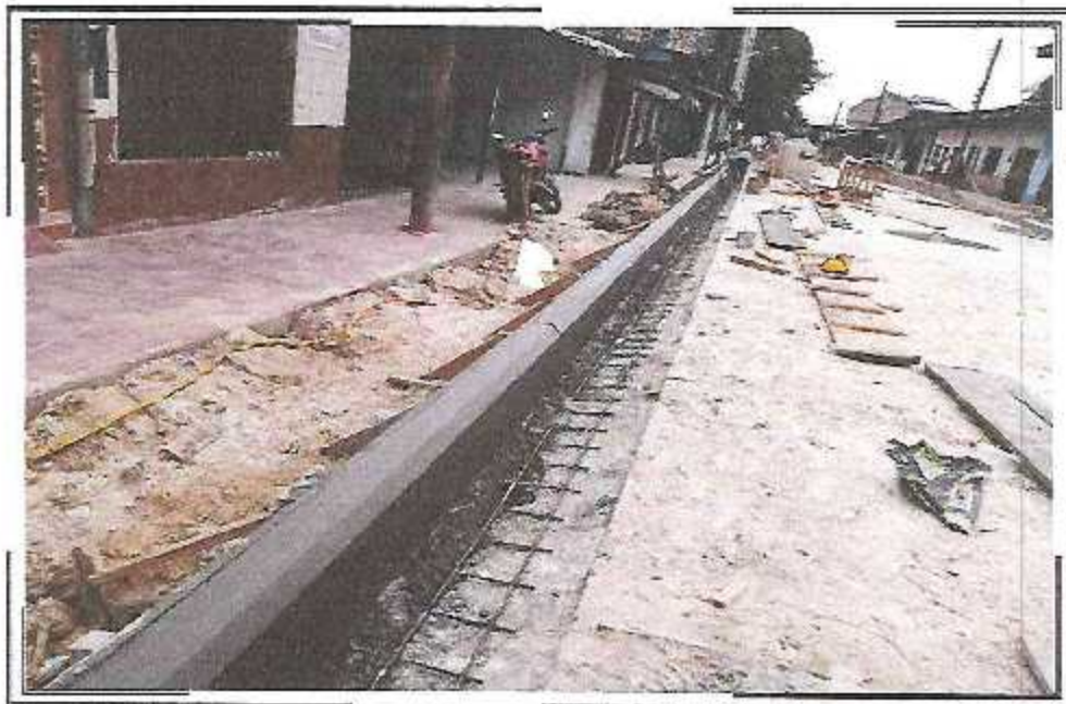
ACABADO DE SERDINEL PSJ QUIÑONES TRAMO II
