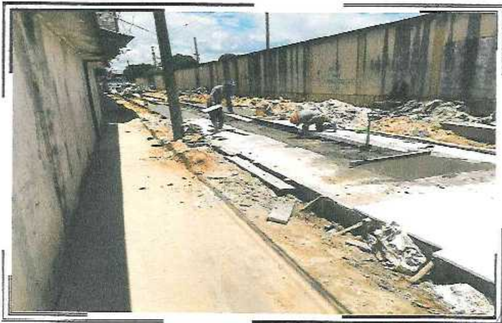
VACEO DE LOSA DE RODADURA F_c = 210 kg PSJ QUIÑONES / AV. MARISCAL CACERES.
