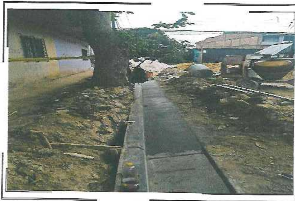
VACEO DE SARDINELA Y CUNETAS PSJ QUIÑONES TRAMO III ( PSJ ASTAO / AV DEL EJERCITO)
