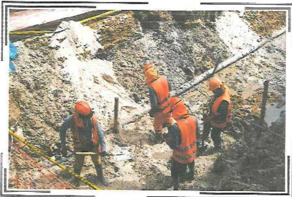
PERFILAMIENTO DEL TERRENO PARA EL CANAL DE 0.80 X 0.80 DEL PSJ. GONZALES VIGIL
