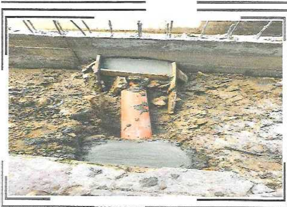
COLOCACION DE TUBOS DE MORTEROS EN LA CONEXIONES DE DOMICILIARRAS DEL DRENAJE PLUVIAL DEL PSJ. QUIÑONES TRAMO I
